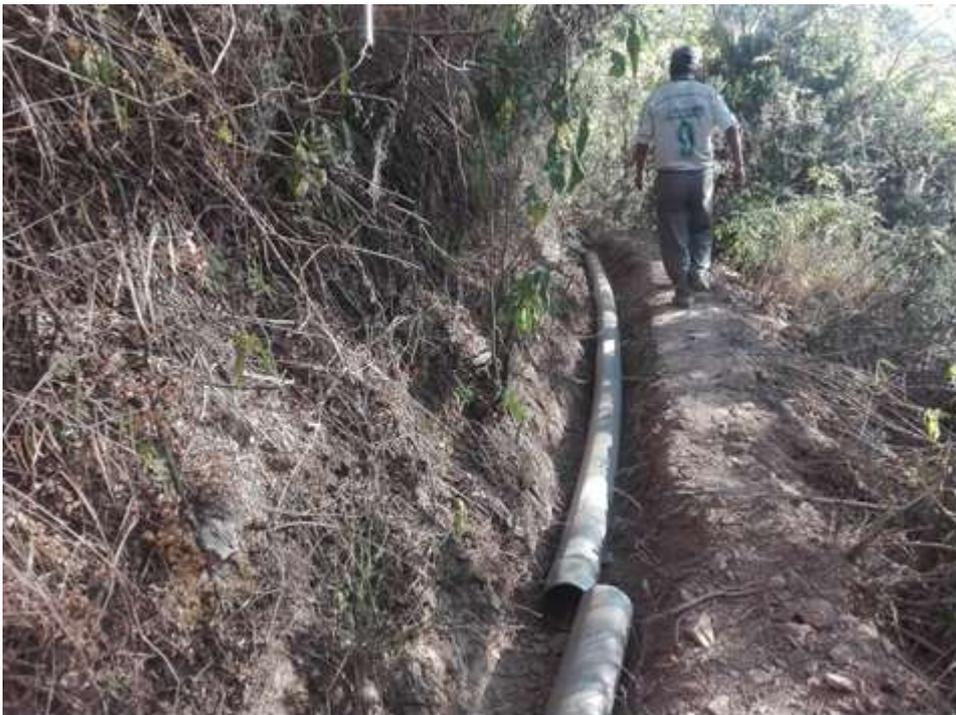
Ausgrabung und Verlegung der 133 Rohre, in der Länge von 800m
